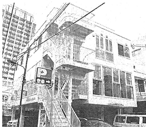
白砂商事が保有する駐車場の有効活用策として建設されたビル。2階をオフィス、3階をシェアハウスとした。都心立地が特徴=東京都千代田区
