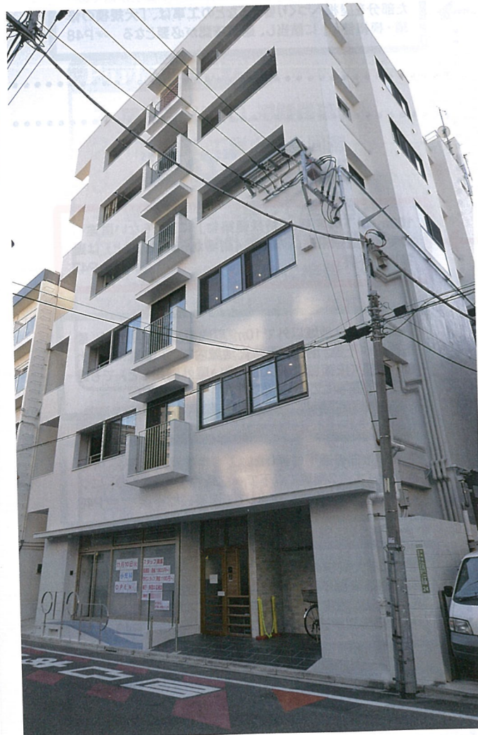
【写真1】印刷会社の工場を複合ビルに改修 設計当初は保育所とシェアハウスだけが決まっていた。建築確認申請は先に全体の大規模修繕と4階の用途変更だけ出し、その後、1~3階と、5、6階を加え、2回計画変更した(写真:本誌)
