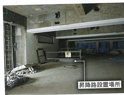
4階以上と同様に、2、3階にも付室や避難上有効なバルコニーを設けた。だが、保育所と住民の動線を分けるために屋内に階段とエレベーターを新設した。写真はそのために床のストラップを抜いている工事の様子（写真：北仲34）
